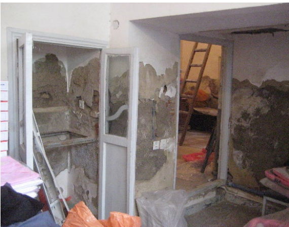
شکل ۱. نمونه‌هایی از نشست، ریختن سقف‌ها و طاق‌ها بر اساس فرسایش محیط (تصویر بالا سمت چپ) و همینطور، تخریب عمده سازه، از قبیل تخریب سقف‌های سازه‌ای و ایجاد بالا بر (تصویر بالا سمت راست)، کاشی‌کاری، تراشیدگی دیوار و حذف طاق‌ها و ایجاد سقف‌های تخت (تصاویر پایین).
