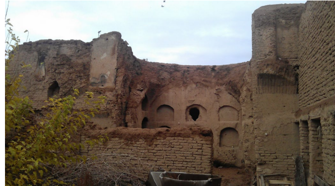
نمای خارجی جبهه غربی
