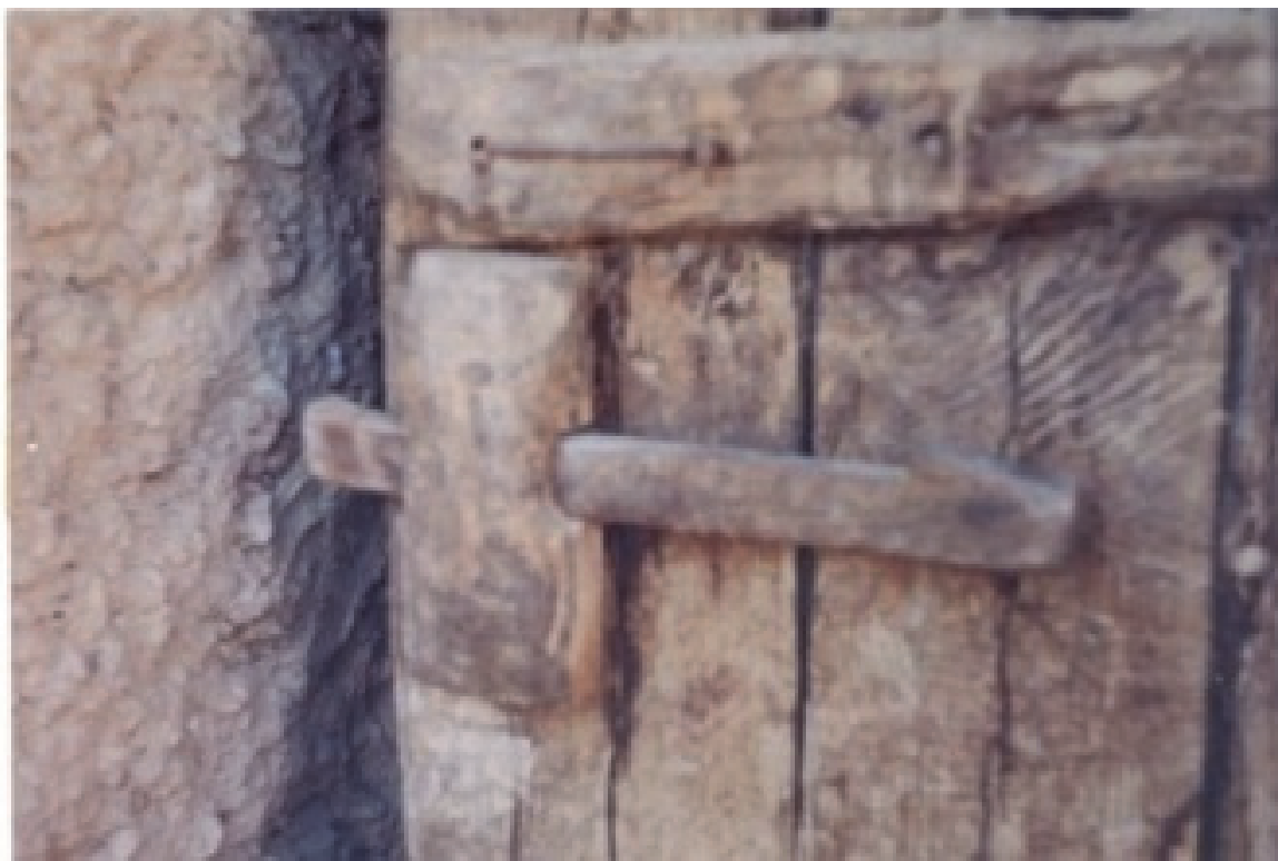
شکل ۳۷. شب‌بند در حیاط بیرونی
