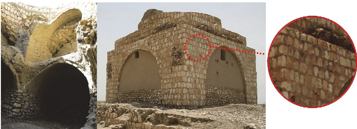
شکل ۱۰. راست: مصالح مورد استفاده در ساخت بنا، چپ: سازه خشتی الحاقی بنا
