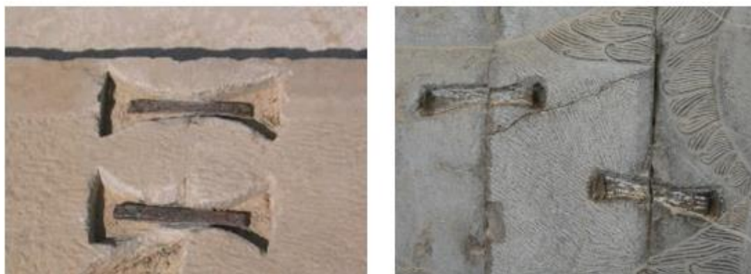
شکل ۱۲. چپ: استفاده از بست‌های فولادی موسوم به دم چلچله‌ای با پوشش سرب جهت دوخت و دوز بلوک‌های بزرگ سنگ در بنای
