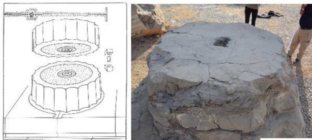
شکل ۱۳. چپ: نمونه‌ای از اتصالات استفاده شده به منظور ممانعت لغزش قطعات قلمه ستون (Nylander, 1970: 38)؛ راست: ایجاد
