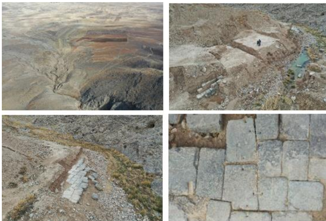
شکل ۵. موقعیت سد دیدگان (بستان‌خانی) نسبت به دشت و کوهستان و جزئیات سازه معماری مربوط به خروجی آب و شواهدی از اتصالات بلوک‌های سنگی توسط بست‌های فلزی (کریمی، ۱۴۰۱)
