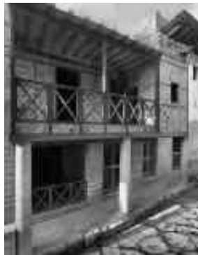
شکل ۱. خانه‌ای با سیستم کراتی در هرکولانیوم (Langenbach, 2008)
