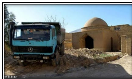
شکل ۱۱. دیوار تخریب شده (Kashfi, 2011)
