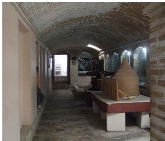
شکل ۷. خانه کلاه‌دوزها، یزد، غلام‌گرد یا مردگردها درواقع ناکش‌های بزرگی هستند که از رسیدن رطوبت به ساختمان جلوگیری می‌کنند. شوره‌زدگی نشانه رسیدن رطوبت به جداره‌های سمت حیاط ناکش و تبخیر آن و نشانه درست کارکردن ناکش‌هاست.
