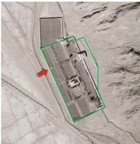
شکل ۴. وضعیت اولیه دیوارکشی و ورودی باغ بیرم‌آباد در دوره اولیه ساخت
