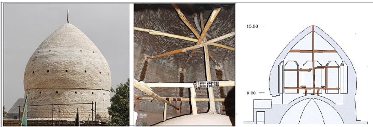
شکل ۱۲. طرح کلاف بندی داخل گنبد مقبره شیشه شه، منبع: Bavand Consulting Engineers, 2007
