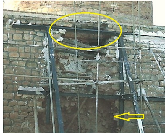
شکل ۱۸. بالای تصویر، ادامه پایه گنبد در پشت دیوار الحاقی و پایین تصویر، فضای بین بنای اصلی و دیوار بیرونی با مصالح متخلخل پر شده است را نشان می‌دهد. (مأخذ: آرشیو میراث فرهنگی لرستان)
