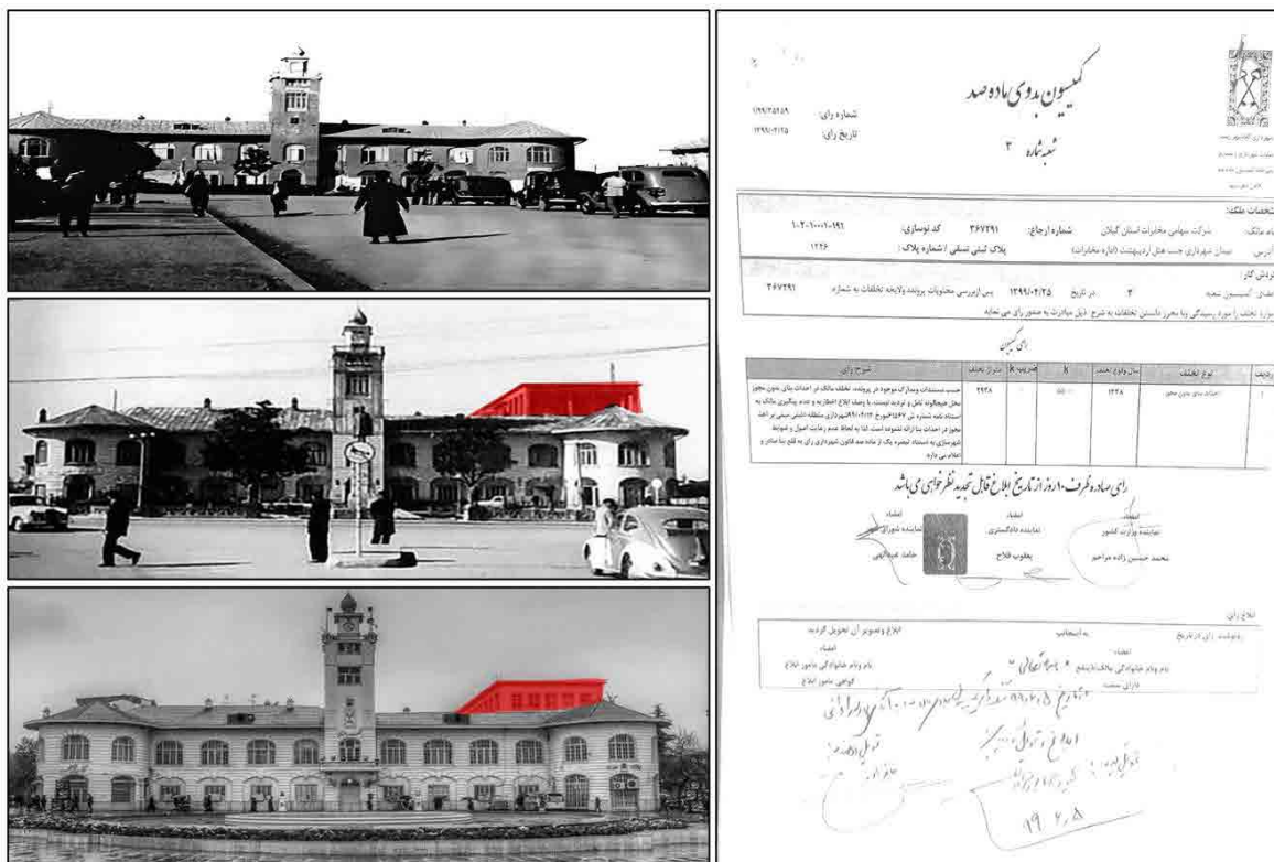
شکل ۴: رأی کمیته ماده ۱۰۰ مبنی بر تخلف و لزوم قلع بنا (راست) (شهرداری رشت، ۱۳۹۹)؛ مخدوش شدن خط آسمان تاریخی غرب میدان و کاهش ارزش بصری عمارت شهرداری در ادوار مختلف (چپ) Fig. 4: Decision of the Article 100 Committee confirming the building violation and ordering the demolition of the unauthorized construction (right) (Rasht Municipality, 2020); progressive deterioration of the historic skyline along the western edge of the square and the consequent decline in the visual significance of the Municipal Building over time (left) (Authors, 2025).
