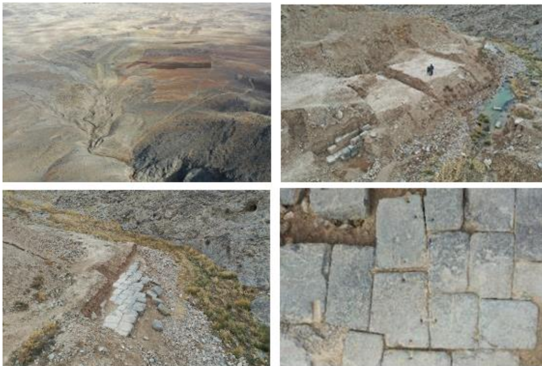
شکل ۵. موقعیت سد دیدگان (بستان‌خانی) نسبت به دشت و کوهستان و جزئیات سازه معماری مربوط به خروجی آب و شواهدی از اتصالات بلوک‌های سنگی توسط بست‌های فلزی (کرمی، ۱۴۰۱)
