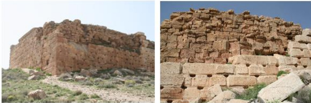
شکل ۱۴. نمایی از بنای تختگاه پاسارگاد (تل تخت)، دیواره درونی برپا شده با ماسه سنگ‌های نامنظم و نمای بیرونی آراسته شده با سنگ‌های چهارگوش سفید آهکی (فدایی، ۱۴۰۱)
