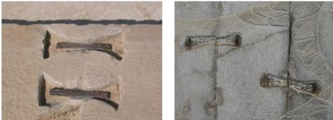
شکل ۱۲. چپ: استفاده از بست‌های فولادی موسوم به دم چلچله‌ای با پوشش سرب جهت دوخت و دوز بلوک‌های بزرگ سنگ در بنای کاخ بارعام؛ راست: وصله‌کاری قطعاتی از نقوش برجسته در تخت‌جمشید (مرکز اسناد پایگاه میراث جهانی تخت‌جمشید) Fig. 12. Left: Use of steel fasteners, known as swallowtail clamps, with lead coating to stitch large stone blocks in the Palace S; Right: Patching of pieces from reliefs at Persepolis (World Heritage Persepolis Documentation Center)
