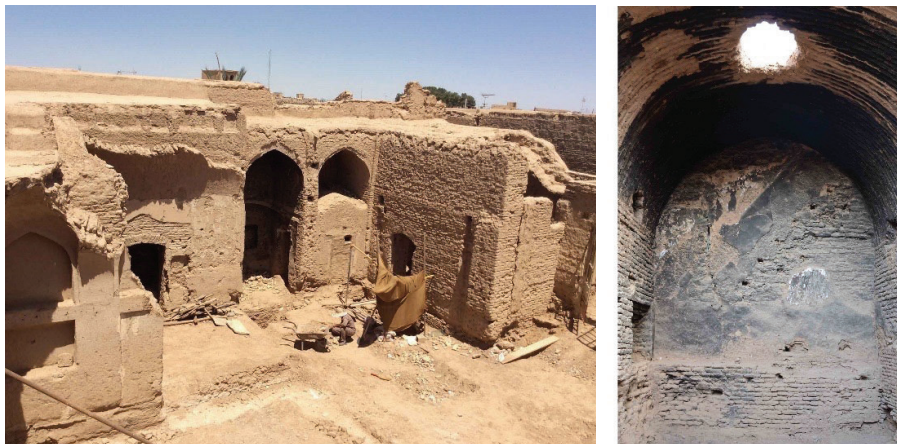
شکل های ۱۶ و ۱۷. چپ: حجم افزوده اتاق شمالی که به ضلع غربی متصل شده و ضلع شرقی که از بین رفته است. راست: داخل اتاق شمالی.
