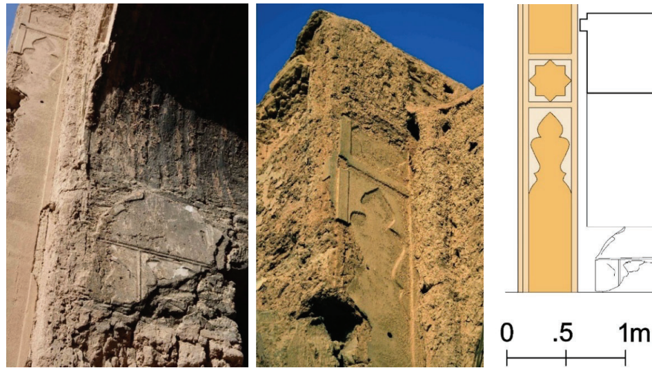
شکل ۱۲، ۱۳ و ۱۴. آرایه‌های گل‌بری با رویه گچ بر سرجرز ایوان (راست و وسط) و داخل غرفه غربی حیاط (چپ).
