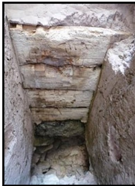
شکل ۱۵. تیرهای چوبی ضخیم سقف (Dan et al., 2018)
