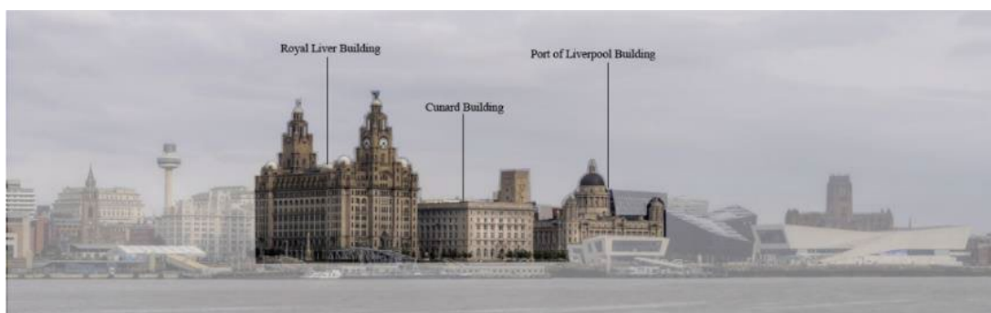
شکل ۳. سه ساختمان واقع در پیرهد
